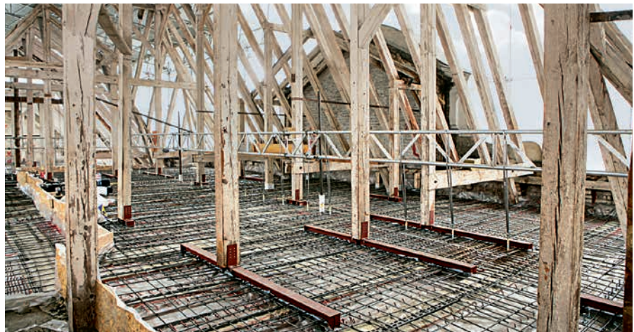
Mit Holz-Beton-Verbundsystemen lassen sich Decken nachträglich ertüchtigen.
