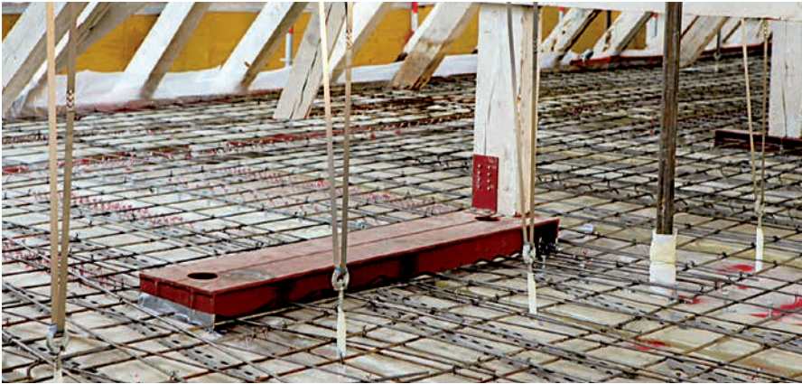
Während des Betoniervorgangs wird die Holzbalkendecke unterstützt.
