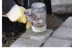
Pflaster hammerfest in Drain-Bettungsmörtel setzen
