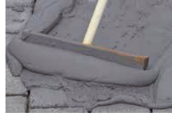
Zementmörtel mit Gummischieber einbringen
