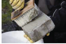
Belagsunterseite mit Kontaktschlämme einstreichen
