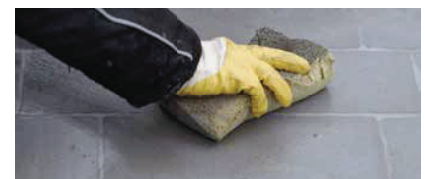
Alternativ kann bei Plattenbelägen die Abreinigung der Belagsoberfläche mit einem Schwamm erfolgen.
