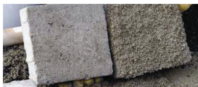
Nur unter Einsatz der Kontaktschlämme erzielen Sie einen vollständigen Haftverbund zwischen Betonstein und Bettungsmörtel!
