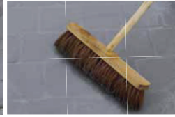
Zementfugenmörtel mit nassem Besen anemulgieren
