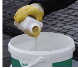
Bindemittelkomponente zugeben und homogen aufrühren
