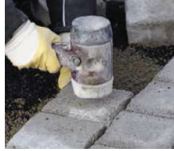
Pflaster in Drain-Bettungsmörtel hammerfest setzen
