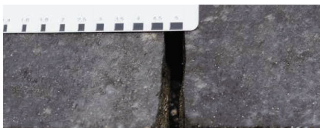
Profitipp: Die Mindestfugenbreite muss durchgängig vorhanden sein. Achten Sie hierauf bei Belägen mit Abstandhaltern.
