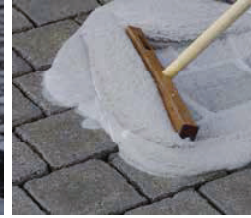
Eimerinhalt mit Gummischieber einbringen
