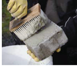
Belagsunterseite mit Kontaktschlämme einstreichen
