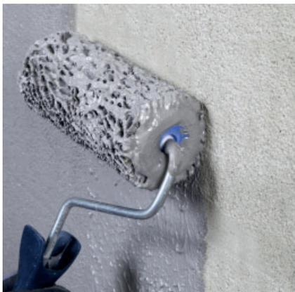
Aufbringen einer Kontaktschicht mit dem Roller.
