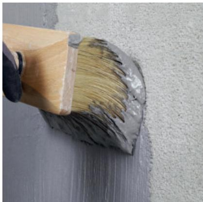
Aufbringen einer Kontaktschicht mittels Bürste oder Quast.
