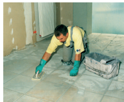
Mit PCI Flexfug können Fugen von 2 bis 10 mm bzw. von 3 bis 15 mm (abhängig vom Farbton) rissfrei verfugt werden.
